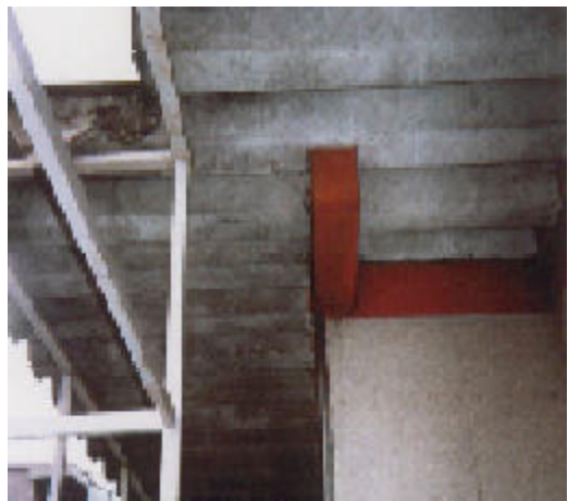
宿河原保育園 屋根の裏側全面にフェルトン
